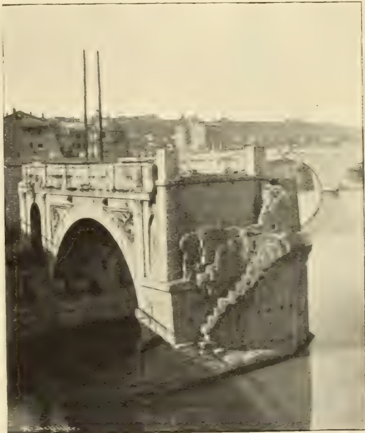
Abbildung 13. Der erhaltene Pfeiler, Ansicht von Südosten.
